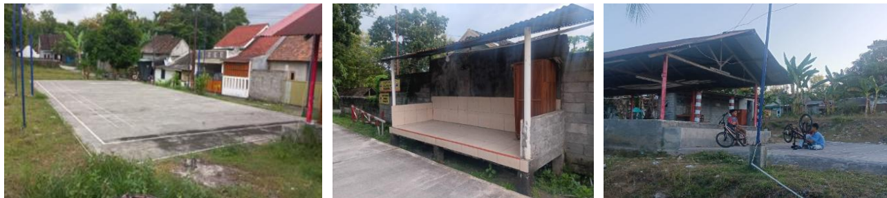
Gambar 3, 4 dan 5. Prasarana Lingkungan di Perumahan Guwosari Indah Blok 2
