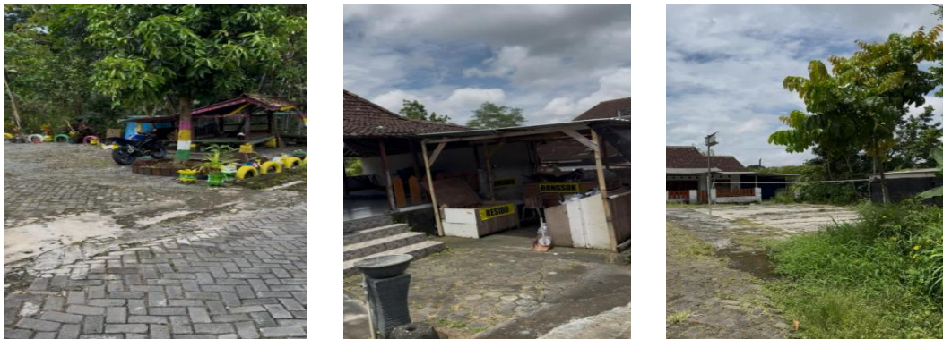
Gambar 9, 10, dan 11. Prasarana Lingkungan di Perumahan Guwosari Blok 6
